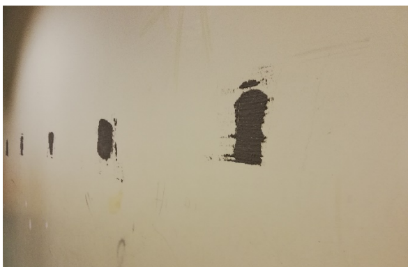
Wand im 1er-Trakt (FDG)
